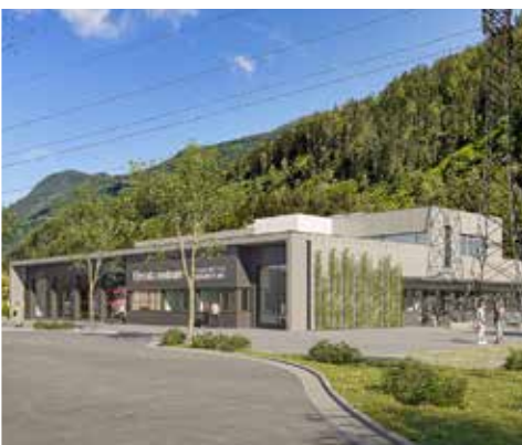
Einsatzzentrum, Schönwies Einsatzzentrum für die Feuerwehr und Bergrettung
