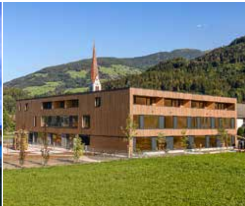
Haus der Generationen, Volders Multifunktionsgebäude mit 13 betreubaren Mietwohnun- gen, 8 Kindergartengruppen, 4 Kinderkrippengruppen, Vereinsräumlichkeiten
